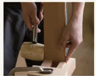
仕上げ・施工
